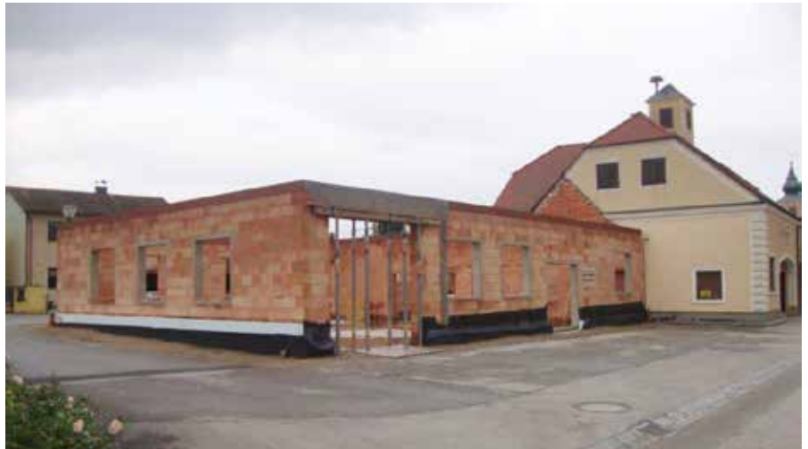
Baufortschritt des Feuerwehrhauses in Langmannersdorf
