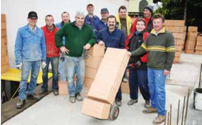
Die Murstettner arbeiten schon fleißig am neuen Feuerwehrhaus
