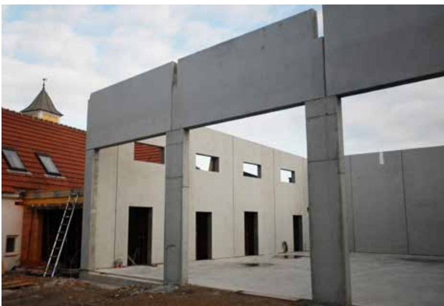
Das neue Feuerwehrhaus 2 Monate später...
