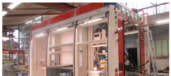
Unser neues Rüstlöschfahrzeug 3000/200-Tunnel im Rohbau
